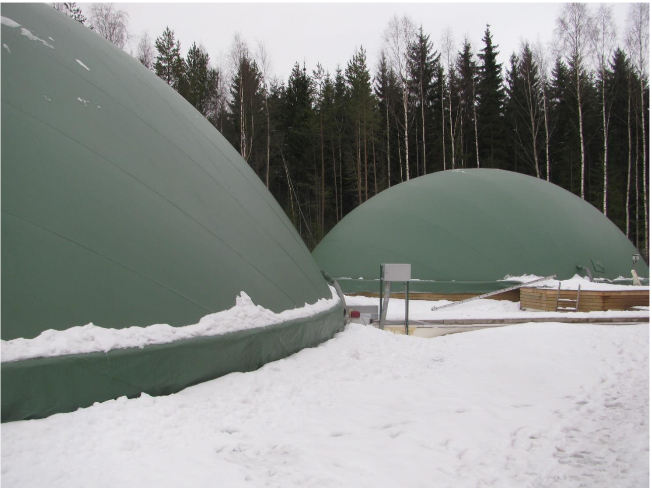
Kuvassa Metenerin Joutsan biokaasulaitoksen kaasukupoleja
